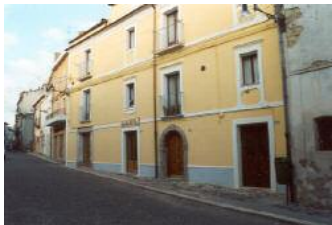
(Larino: edificio di via Cluenzio - centro storico)
