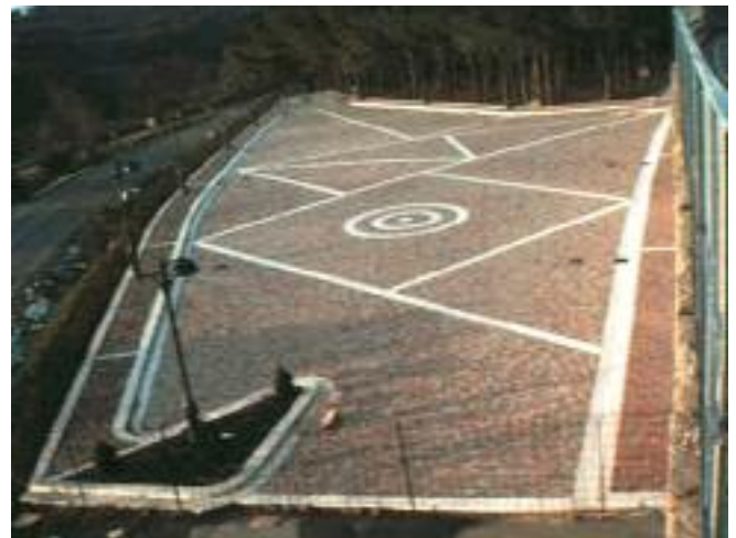
(Lavori di sistemazione della pineta comunale)
